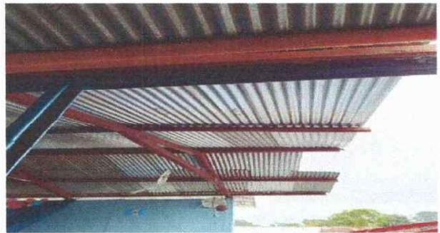
Foto 6: Cambio de estructura de techo, material de metal por metal.
