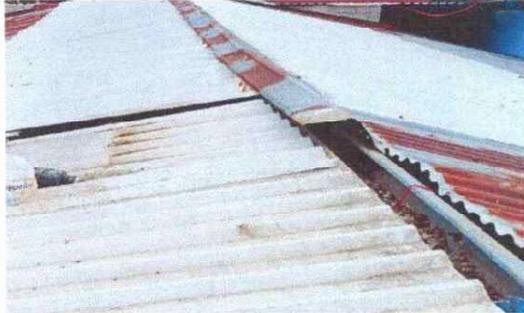
Foto1: Cambio de láminas por láminas troqueladas.
